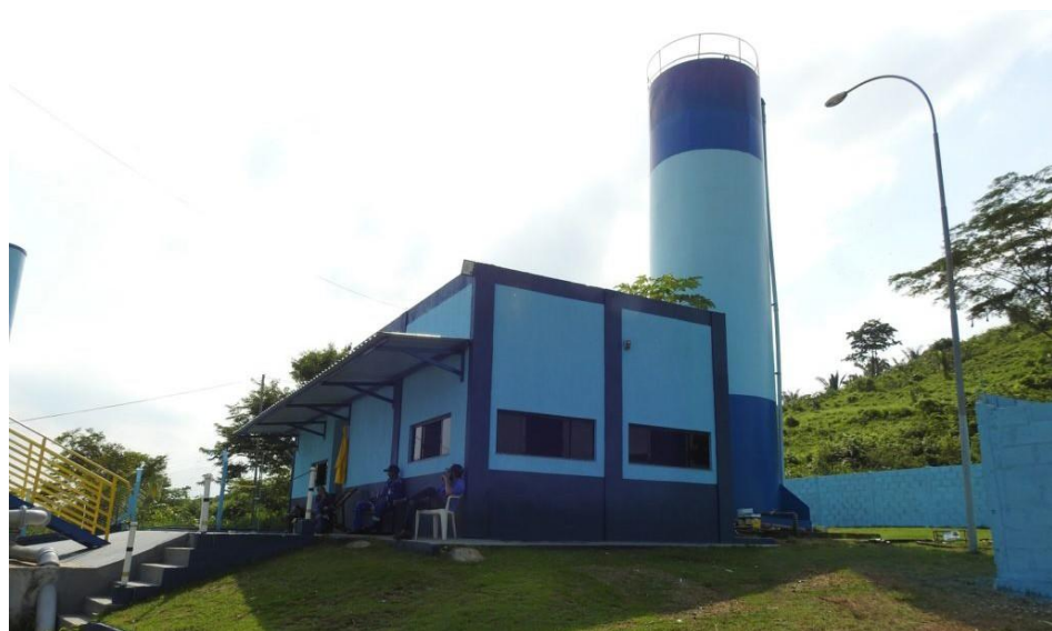
Figura 2. Estrutura física da ETA 3. Serviço Autônomo de Água e Esgoto de Parauapebas, 2021.
