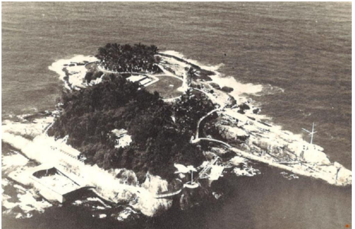
Figura 2 - Ilha dos Arvoredos com primeiras intervenções. Fonte: Acervo FFEL
