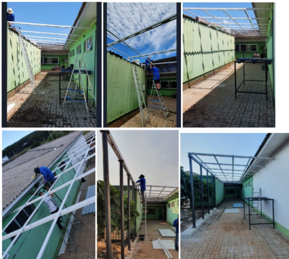
Figura 7 - Montagem da estrutura no local planejado
