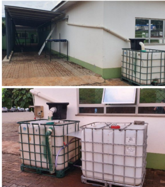
Figura 10 - Instalação do sistema de captação de água pluvial
