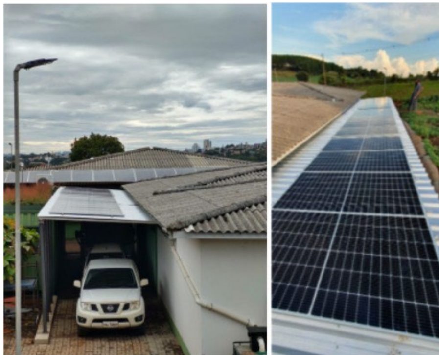
Figura 9 - Instalação das placas fotovoltaicas
