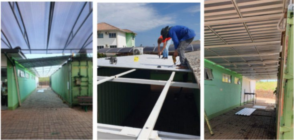
Figura 8 - Montagem da estrutura no local planejado
