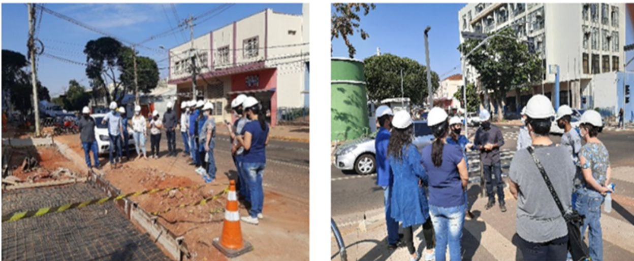
Figura 1: Visita técnica nas obras de requalificação com o GT de Educação Ambiental
