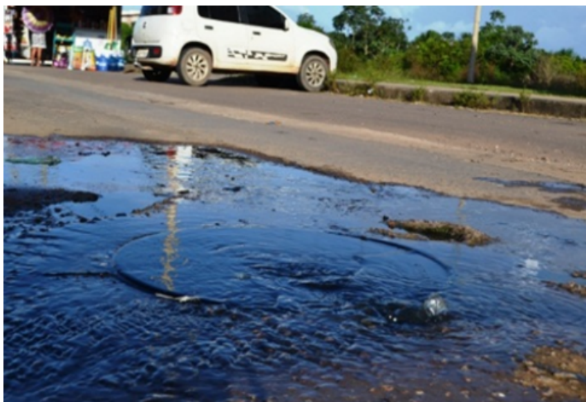
Figura 5: PV 59 localizado próximo à rotatória até o PV 72, passando pelo PV 70 da rotatória 3.
